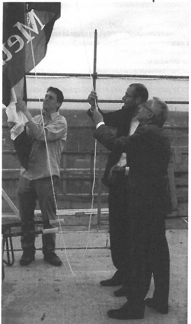
Op 12 juli jl. werd het hoogste punt van de bouw bereikt en daarom werd op het dak de vlag gehesen door Rick Ursem, samen met wethouder Jos van Rey van de gemeente Roermond en een vertegenwoordiger van Meulen Bouw.
